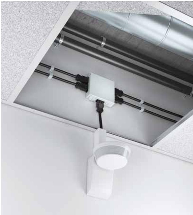
**Verteilergehäuse kompakt PD**
